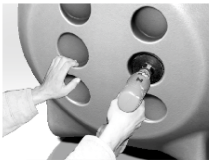
Рис. 13 Сверление отверстия для установки ЗПТ
